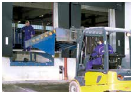
Demontaža starih pretovarnih mostova, eventualno je potrebno prilagoditi rov (na primjer s montažnim pločama ili konzolama)
