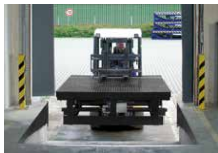
Postavljanje novog pretovarnog mosta
